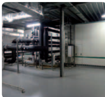
Obr. 3 VZT jednotka s rekuperací
