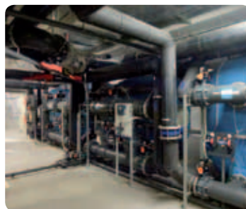
Obr. 1 Technologie úpravy bazénových vod
