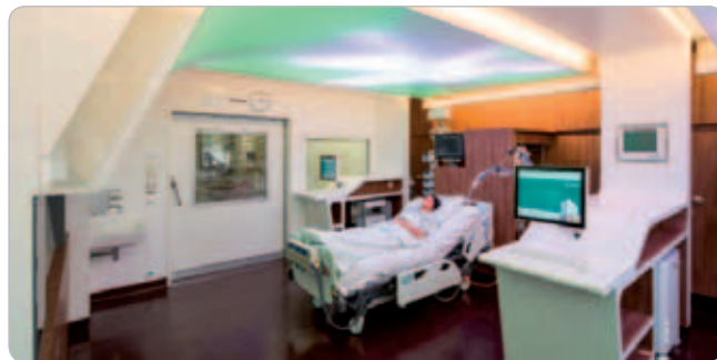
Obr. 3 Stropné osvetlenie je dlhé 7 a široké 2,4 metra. Skladá sa z viac ako 15 400 vysoko výkonných LED diód. Vďaka nim dokáže stropné osvetlenie produkovať svetelný výkon porovnateľný so svetlom žiariacim z jasnej oblohy.
