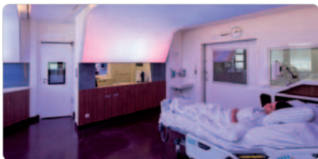
Obr. 2 LED stropné osvetlenie simuluje dynamické denné osvetlenie
